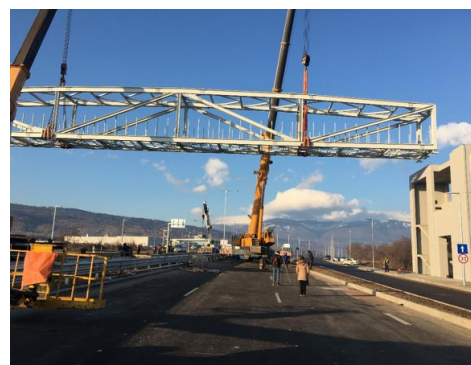
в) окончателен монтаж върху рамките-устои
