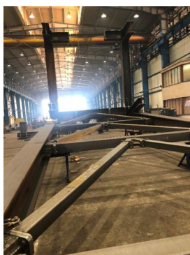
а) заводски пробен монтаж
