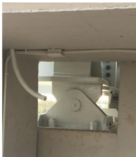
а) основни части на стоманобетонния подход б) реализирано лагерно устройство тип болтова става
