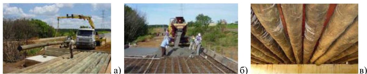
Фигура 2. Моста Campus II USP, Бразилия, с отвор 12 m: монтиране на дървените трупи (а), полагане на бетона (б) и изглед отдолу (в) [36]
