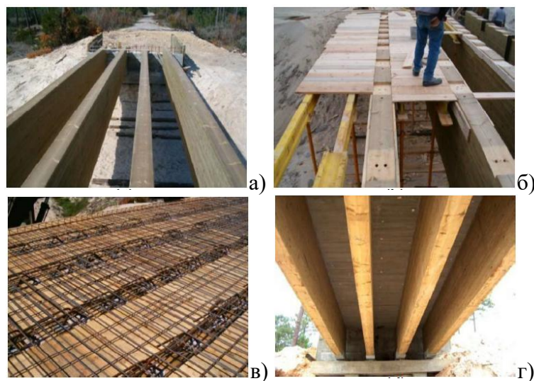
Фигура 3. Моста Quiaios, Португалия, с отвор 15 m: греди от лепена многослойна дървесина (а), кофраж и подпорно скеле (б), армировка и Х-образни дюбели (в) и изглед отдолу (г) [36]
