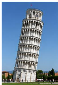
в) Наклоняване и нарастване на ексцентрицитета
