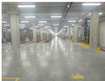
Снимка 1. Безфугова хибридно дисперсно-армирана индустриална бетонна настилка
