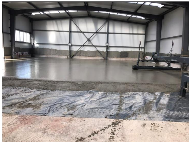
Снимки 1 и 2 Промислено изпълнение на дисперсно-армирана индустриална бетонна настилка с включен BASF Master Glenium Sky 691 в рецептурата на бетона
