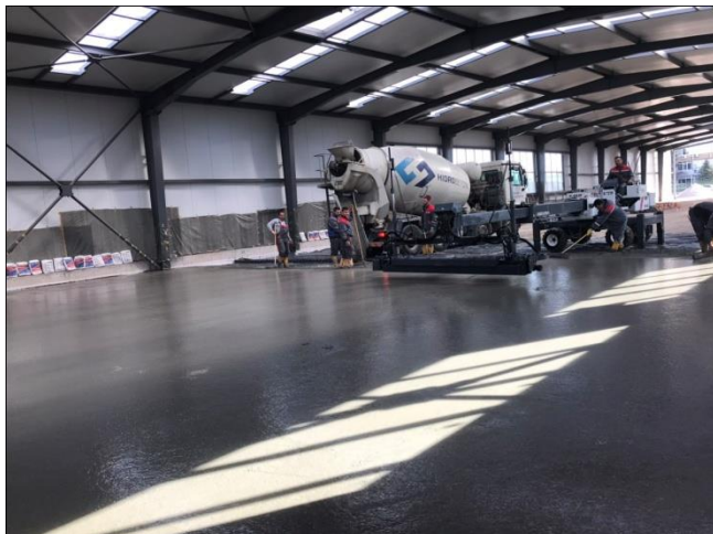
Снимки 1 и 2 Промислено изпълнение на дисперсно-армирана индустриална бетонна настилка с включен BASF Master Glenium Sky 691 в рецептурата на бетона
