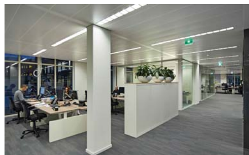
Фигура 2. Работно осветление и аварийно раб.осветление – общ.обслужващ комплекс [7].
