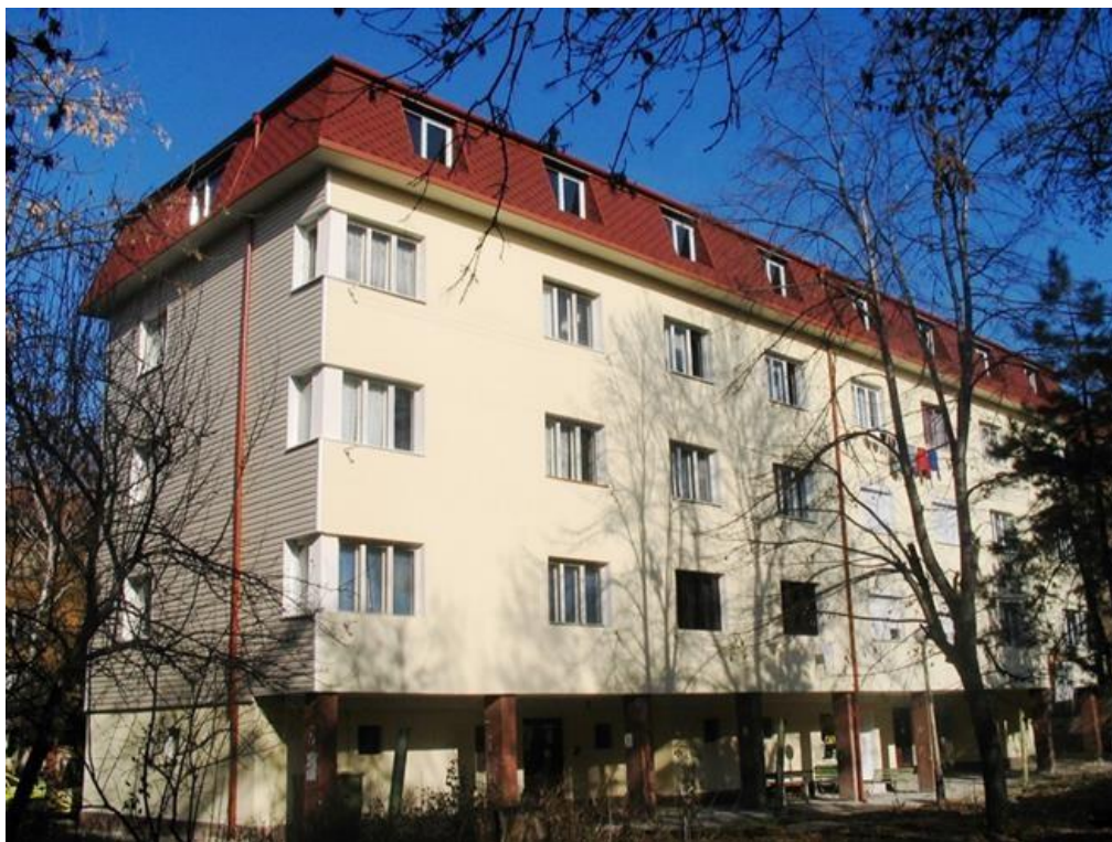
Фиг. 3 Изгледи от реконструираната пилотна сграда – фасади юг – запад,
