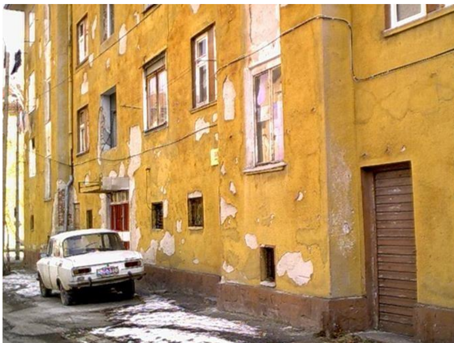
Фиг.2. Сградата в ж.к. „Захарна фабрика“ преди реконструкцията, Изт. арх.Г .Георгиев
