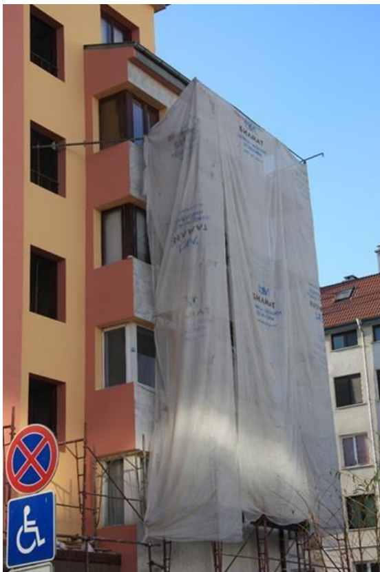
Фиг. 5. Апартаментна сграда на ул. Кирил Божиков 18, гр. София по време на строителните работи. Готовата обновена сграда е показана на интернет страницата на проект REECL. Изт. арх. Георги Георгиев
