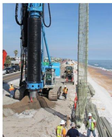
Фигура 3. Полимерна армировка за пилот [3]
