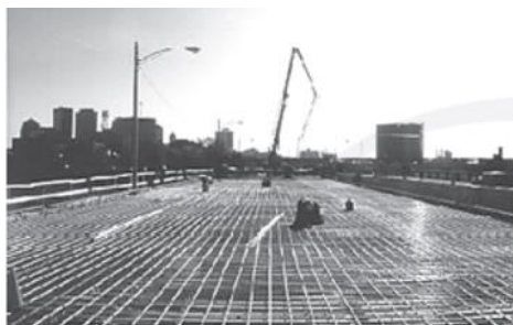
Фигура 1. Полимерна армировка за мостова пътна плоча [1]
