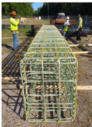
Фигура 2. Полимерна армировка за Halls River Bridge, 2017 [3]
