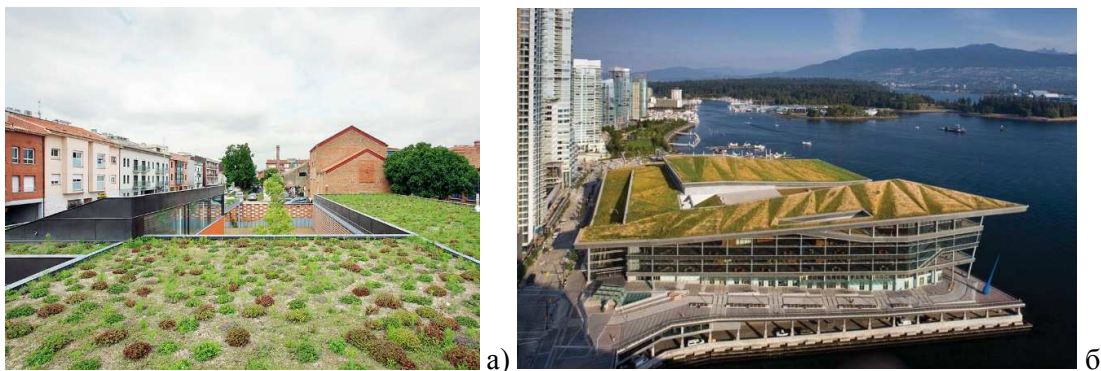
Фигура 1. а) Екстензивен покрив на център за възрастни, Испания. б) Екстензивен покрив на Vancouver Convention Centre, Канада.; (фотография: а) José Nevía; б) Nic Lehoux) [4] [5]
