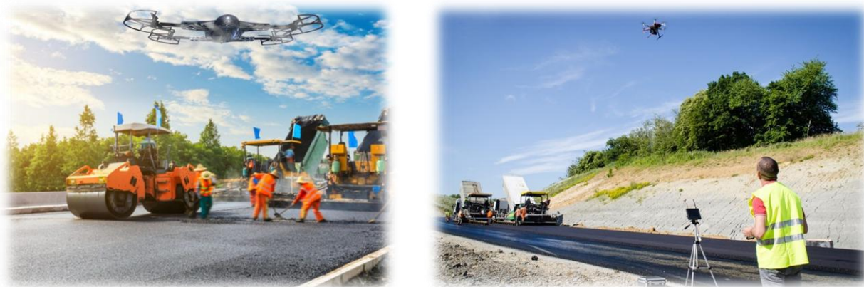
Фигура 1. Наблюдение на строително-ремонтните дейности с БЛС [11]
