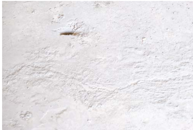
Фотография 4. Пукнатина в подов панел, репарирана по време на строителството
