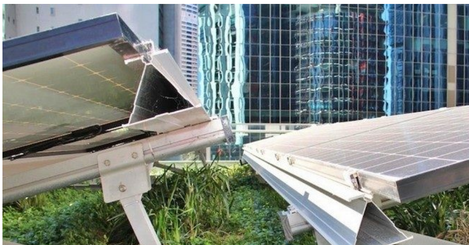
Фигура 1. На зеления покрив растителността помага да се поддържа оптимална температура на работа на панелите, Daramu House, Sydney, Australia (фотография I. Ursula Malone, ABC News Australia) [10]
